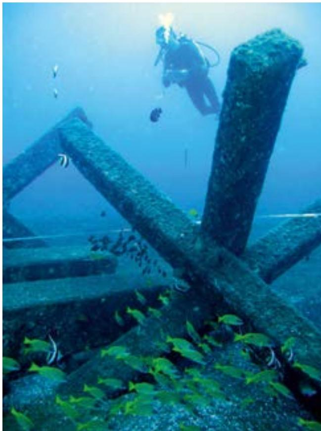
2. Les récifs artificiels produits en France sont généralement en béton armé. Souvent des modules existants comme des buses sont enchaînés en grappes. Parfois des modules sont créés à cet effet. À La Réunion, des poteaux EDF en ciment recyclés ont été assemblés.
